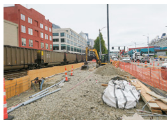
7 現在も進められている歩道などの整備
