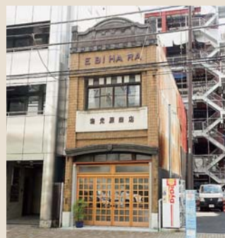
看板建築その3（海老原商店）
