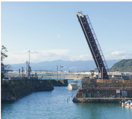
手結港可動橋の下を通り抜ける船舶。橋のたもとには開閉時間の案内板も設置されている。
