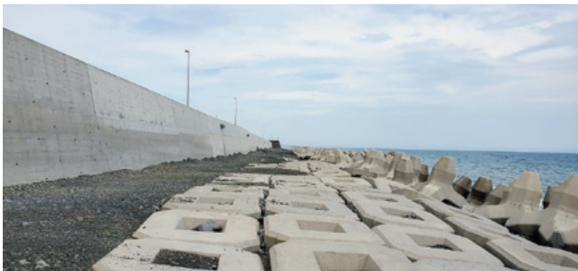
2022年6月末に完了した西湘バイパスの災害対策工事
