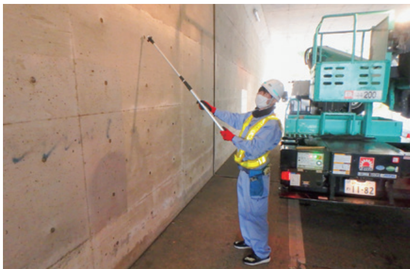
コンクリート構造物の点検（チョーキング）風景
