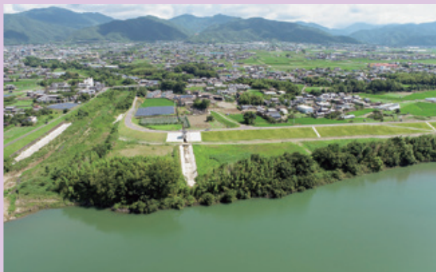
最近完成した堤防のドローン写真
