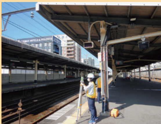
線路の周りに支障物がないかを確認
