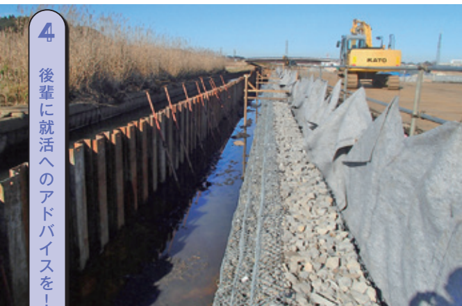
河川護岸工事の現場
