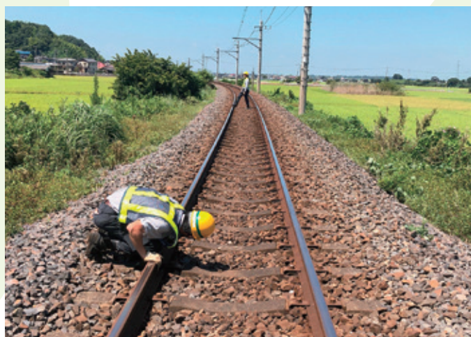
変位の位置と量を確認し、補修延長を調査する
