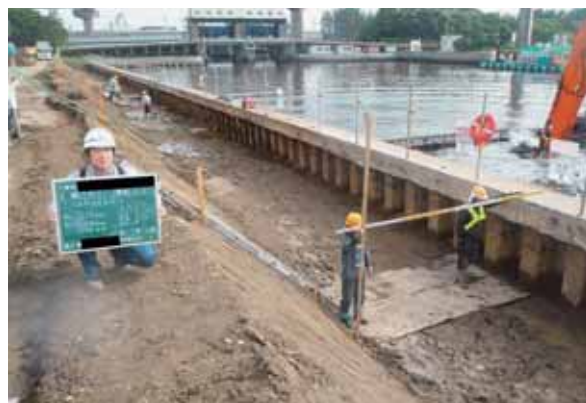
夢の島護岸改修工事の床掘工。掘削土砂出来形確認の立会い
