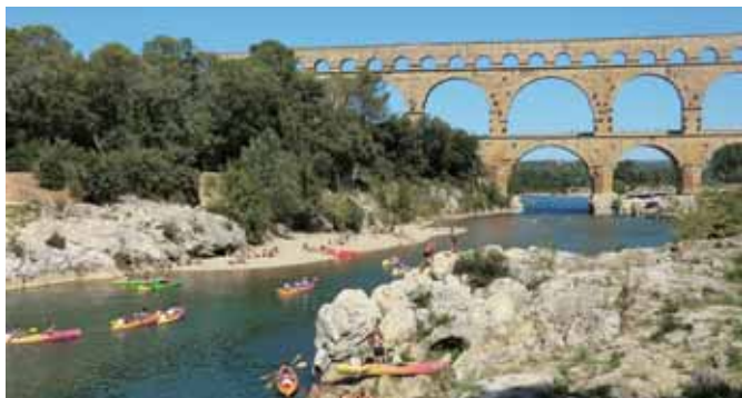
写真-1 ローマの水道橋
